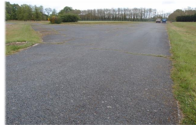
J4.2 – Réseaux routiers
